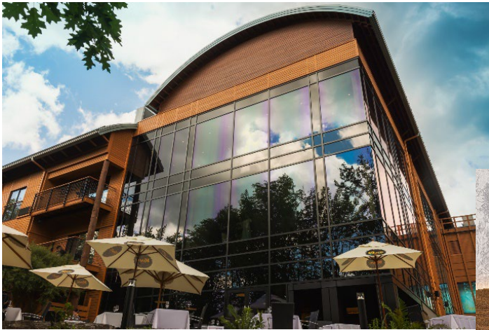
vue extérieure arrière
